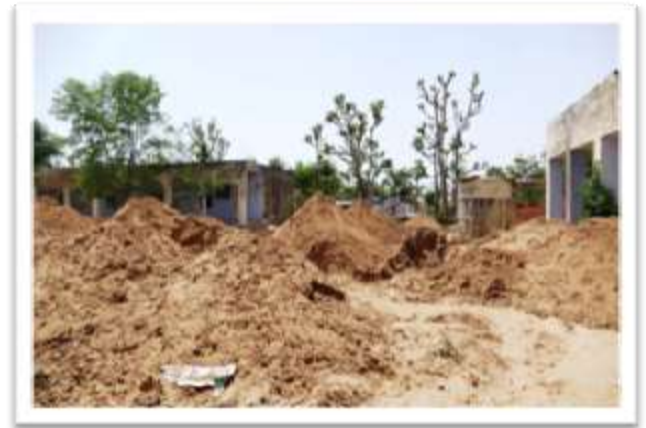
Début des terrassements
