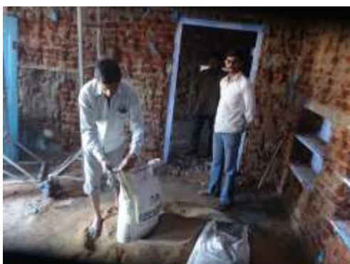
Les travaux dans la salle d'accueil
