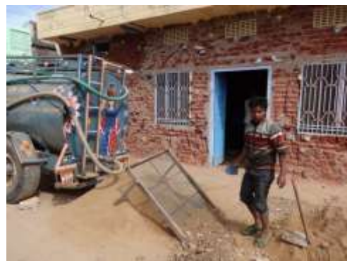
Les travaux : en façade
